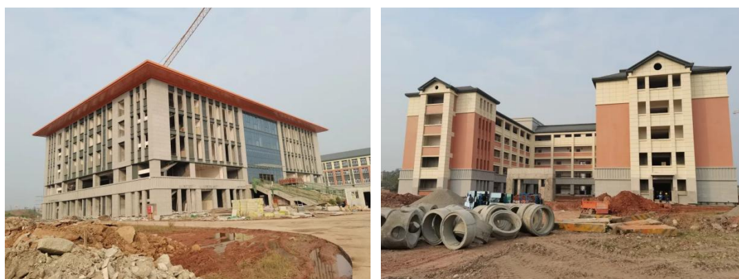
图 5-2 建设中的新校区
